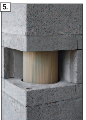
5. Unebenheiten an den Schnittkanten ggf. nacharbeiten.
