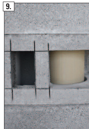
9. Unebenheiten an den Schnittkanten ggf. nacharbeiten.
