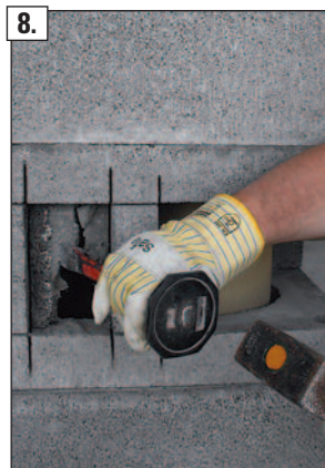
8. Vorsichtig die zweite Mantelsteinschicht mit kleinem Meißel entfernen.
