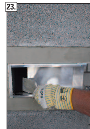
23. Übergang an der Mantelsteinzunge dicht mit Mörtel anschließen.
