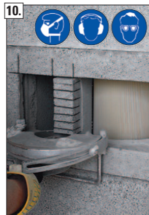
10. Entlastungsschnitte an der Mantelsteinzunge zum Thermoluftzug vornehmen. ACHTUNG! Schnitttiefe max. 70 mm!
