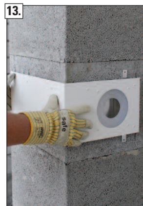
13. Probepassung des LAS Winkel-Zuluft-Adapters vornehmen.
