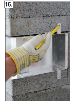
16. Rahmen der LAS Winkel-Zuluft-Adapterblende in Mantelsteinöffnung einsetzen und Bohrlöcher markieren.
