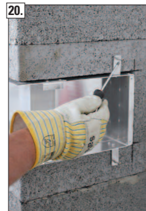
20. Rahmen an den 4 Befestigungswinkeln anschrauben.
