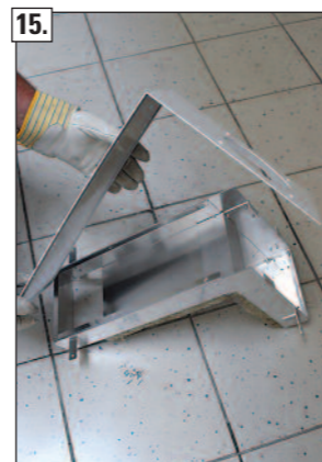
15. LAS Winkel-Zuluft-Adapterblende abnehmen. ACHTUNG! Dichtband dabei nicht beschädigen!
