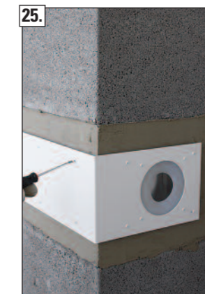
25. Blende auf Rahmen aufschrauben. ACHTUNG! Dichtung dabei nicht beschädigen!
