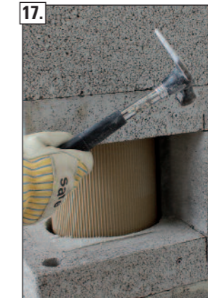
17. Dübel einsetzen.
