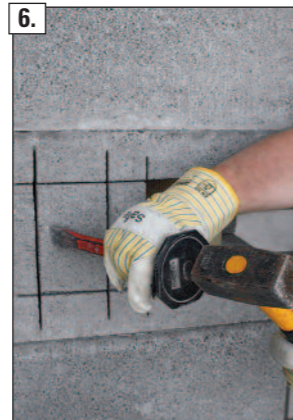
6. Mit kleinem Meißel vorsichtig die erste Schicht des Mantelsteins im Bereich des Thermoluftzugs entfernen.
