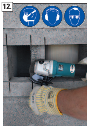
12. Unebenheiten an den Schnittkanten ggf. nacharbeiten. ACHTUNG! Max. 70 mm tief!
