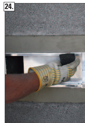
24. Rahmen mit Schwamm vollständig von Mörtelresten befreien und Übergänge zum Mantelstein glattstreichen.
