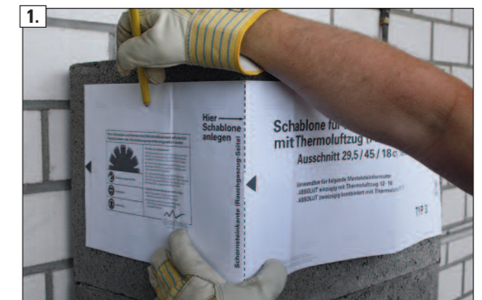
1. Schnittschablone an Mantelstein anlegen und Aussparungen anzeichnen.
