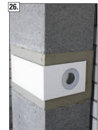
26. Fertigansicht HINWEIS! Die Blende ist vor dem späteren bauseitigen Putzauftrag zu entfernen oder entsprechend vor Beschädigungen zu schützen!
